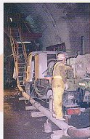
55M 3 モーター駆動&エンジン駆動両用搭載型コンクリートポンプ車
