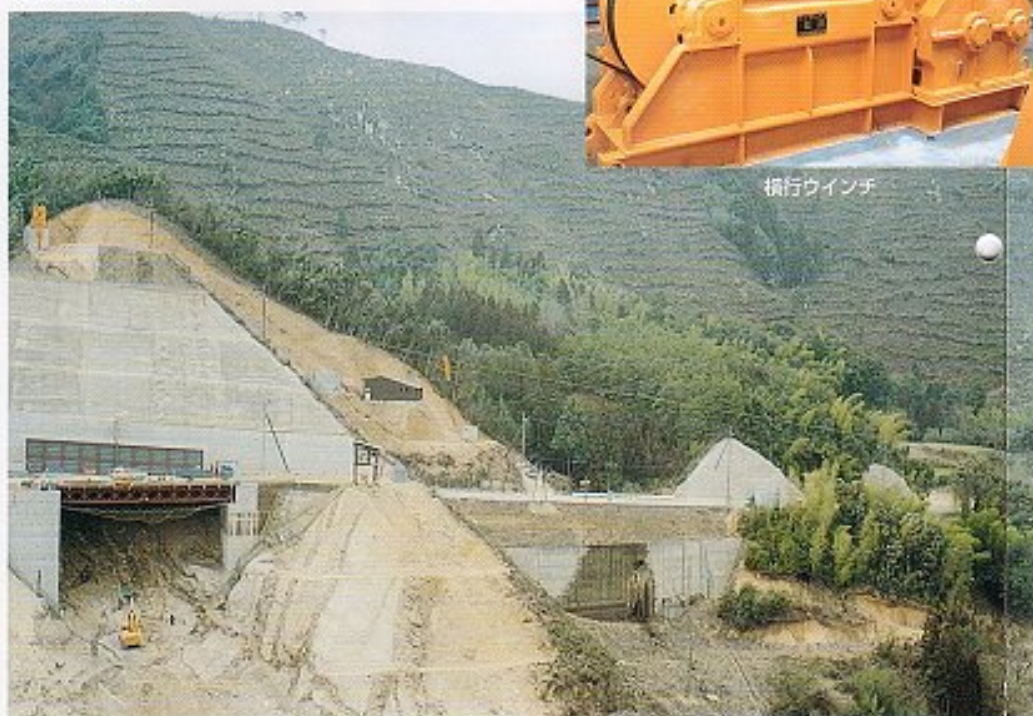
架設現場全体図
