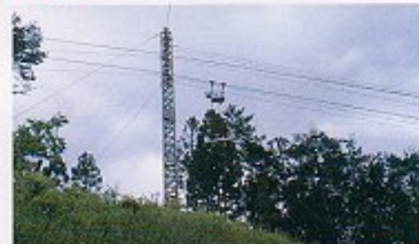
中間支柱のリモコンキャリア通過前
