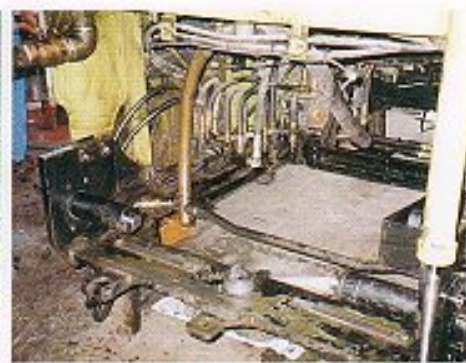
ピストン、面板、ホッパーをフレームより脱着
