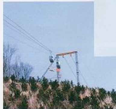
中間支柱で往復運搬中
