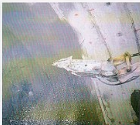
モルタル落し作業中
