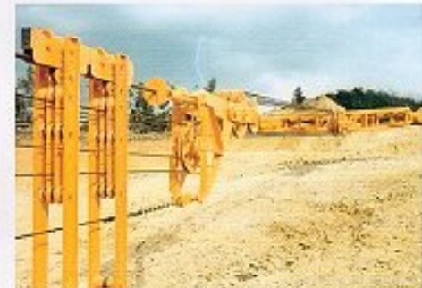
走行トレーラーとロープハンガー
